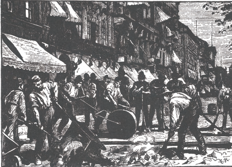
Herstellung der Asphaltstraßen.
